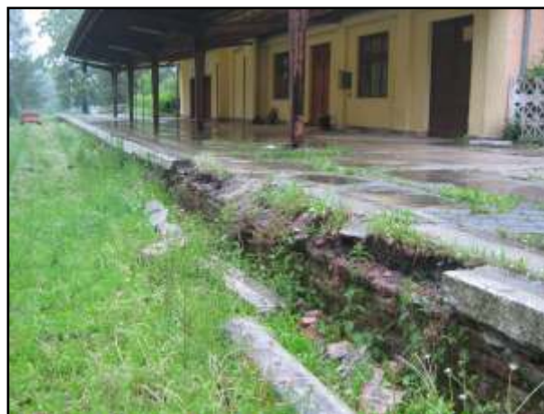
fot. 9. Jako skład budowlany.
