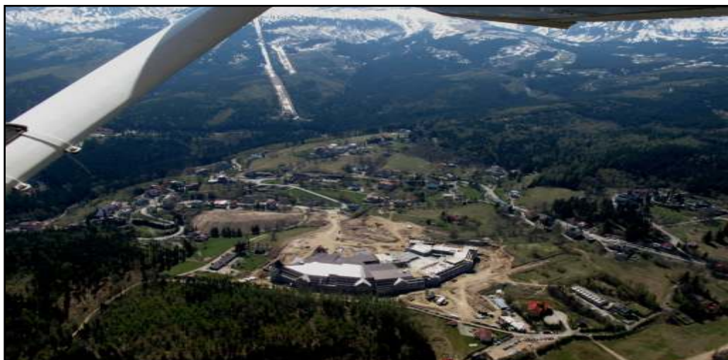
fot. 9. Okolice realizacji hotelu „Gołbiewski” w Karpaczu – zdjęcie lotnicze (autor: S. Lange).
