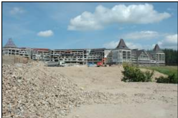
fot. 3. Budowany hotel „Goł biewski” widziany z ul. Karkonoskiej.
