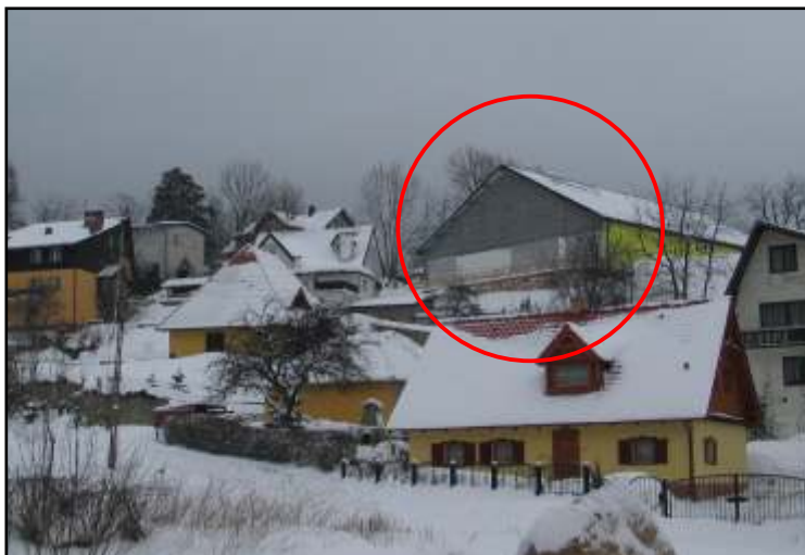
fot. 1. Pawilon handlowy sieci „Biedronka” w Karpaczu spełniający wytyczne miejscowego planu, a mimo to nie wpisujący się w otoczenie – nieodpowiednie ukształtowanie bryły budynku, złe proporcje, fatalne wykonawstwo (ostatnio przeprowadzono remont elewacji i poprawiono najwidoczniejsze błędy wykonawcy obiektu), (fot. autor.).
